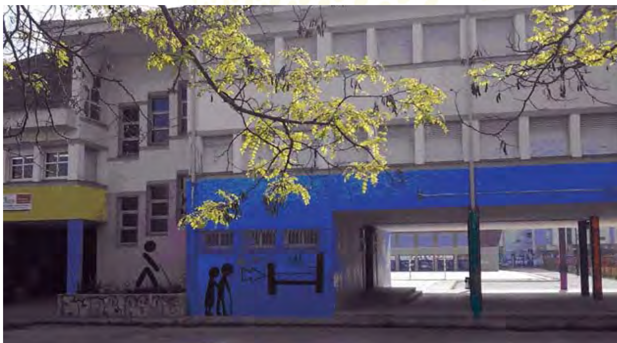
FIG. 1. VISTA GENERAL DEL CENTRO.
